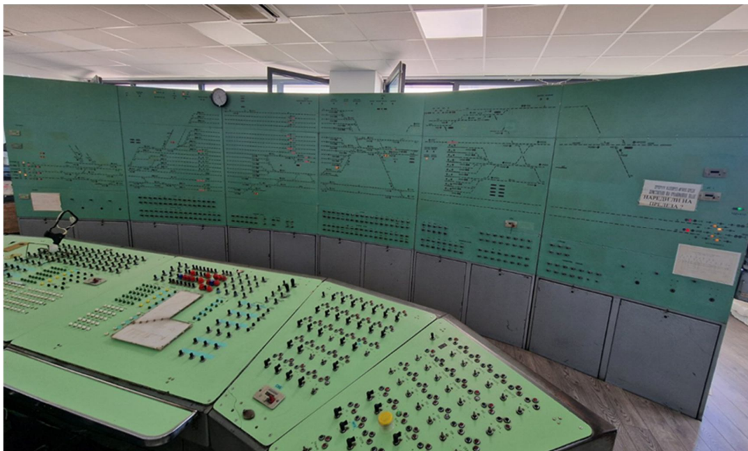
Фиг. 3.6. МРЦ гара Стара Загора с тип „Руска блочна с маршрутизирани маневри“
