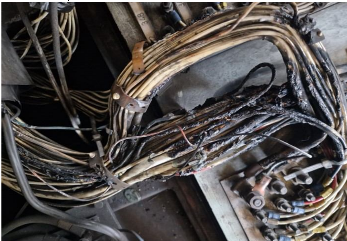
Фиг. 4.16. Обгорели кабели по проводник 870
