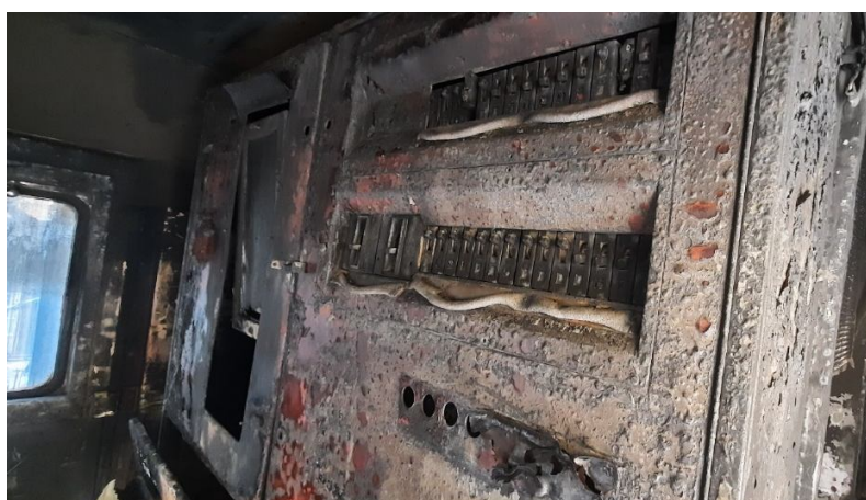
Фиг. 4.12. Състояние на таблото с предпазители в командна кабина № 1 след опожаряването
