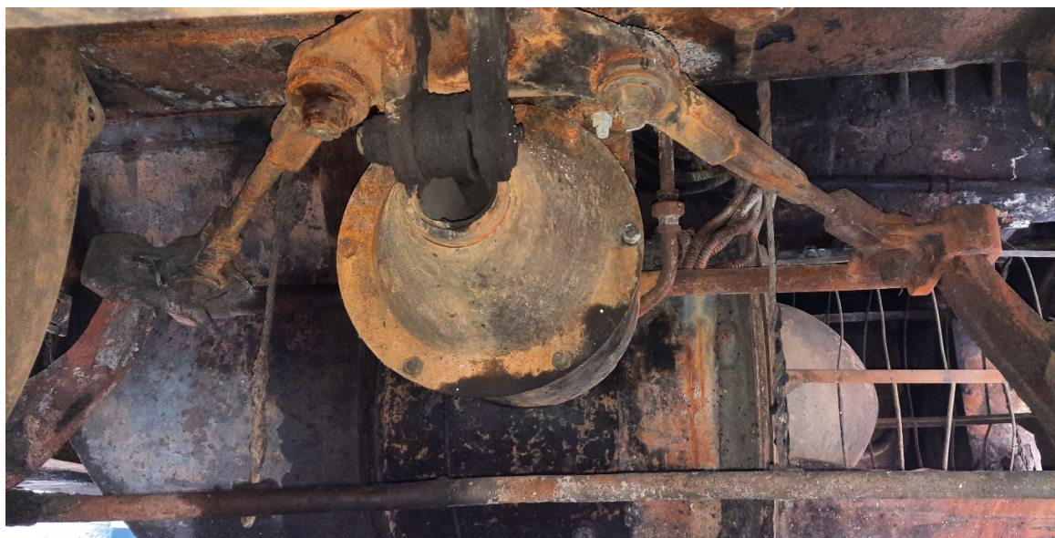
Фиг. 4.13. Състояние на елементи под рамата на локомотива след опожаряването
